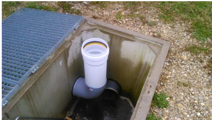
By-Pass avant le dégrilleur
