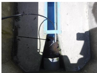
Sortie station, emplacement de la sonde
