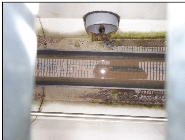
By-Pass avant le dégrilleur
