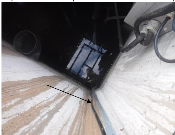
Entrée station (PR1), emplacement de la sonde
