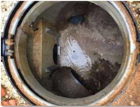
Figure 22: Lame déversante du DO-TRC-05
