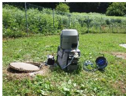
Entrée station, emplacement prélèvement
