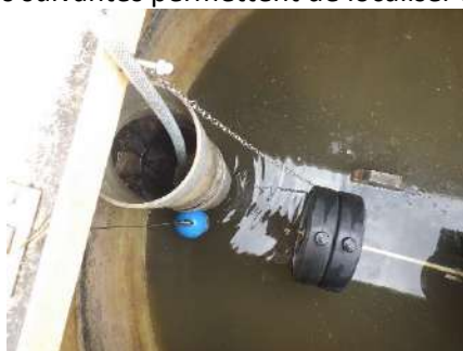
Entrée station, Chasse 1 er étage
