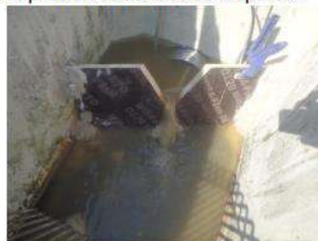
Entrée station, emplacement point de mesure
