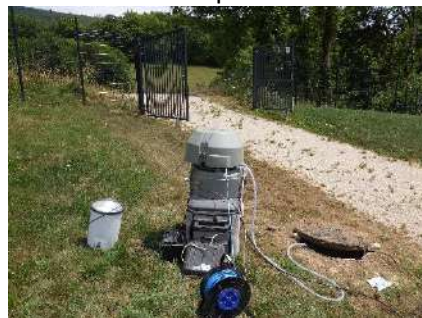
Entrée station, emplacement prélèvement
