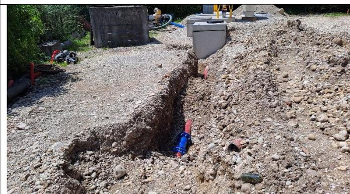
Raccordement hydraulique du réseau réalisé sur la conduite de refoulement
