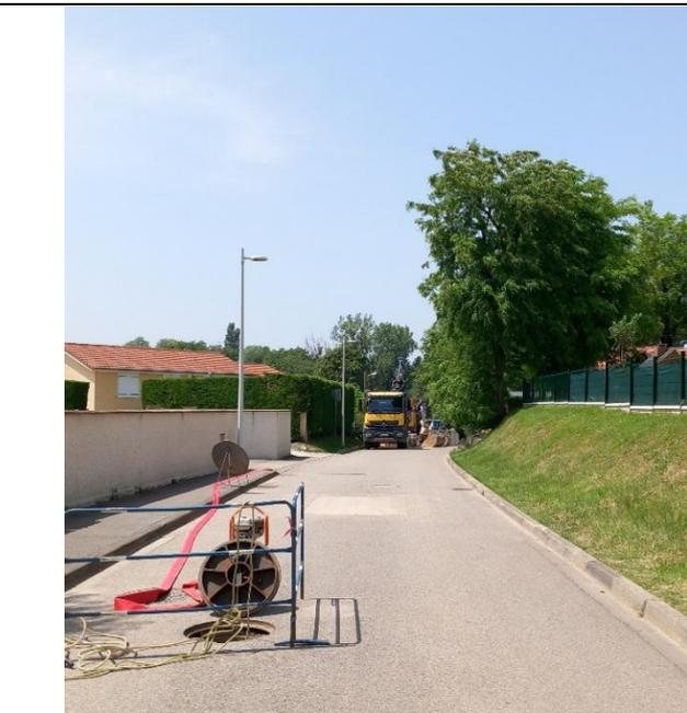
Contrainte de continuité de traitement : pompage provisoire sur 2 antennes du réseau.
