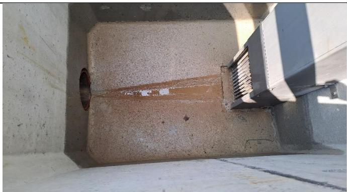
Difficultés : reprise de l'étanchéité de 2 regards (regard EU4 et connexion Ø300 dans regard dégrilleur temps sec)
