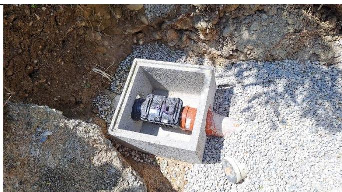
Mise en place d'une boîte à clapet sur un branchement d'eau usée
