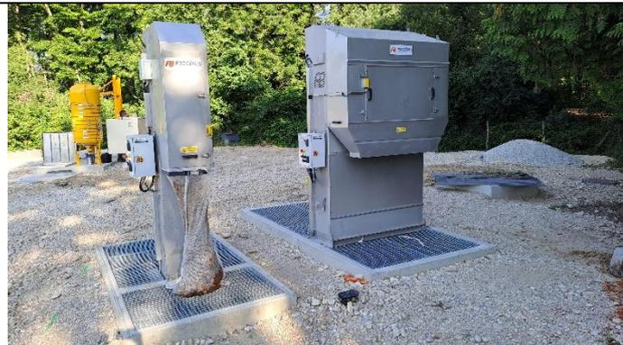
Dégrilleurs temps sec et temps de pluie en fonctionnement
