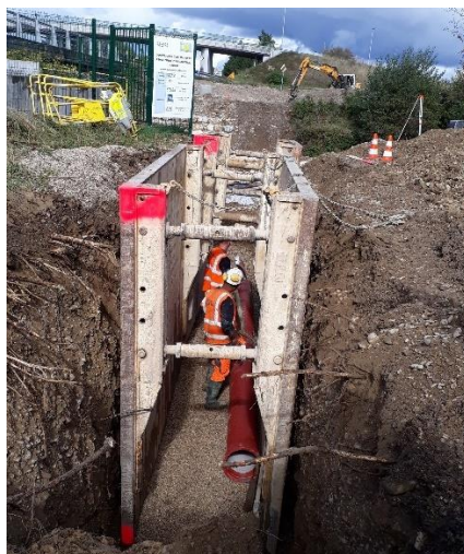
Construction de la canalisation de refoulement
