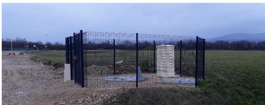
Poste de refoulement de lotissement PR-CTG-09 intégré EN 2019
