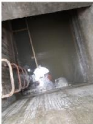
St Denis Remontée de l'Albarine au dessus du seuil Mesure de débit inopérante
