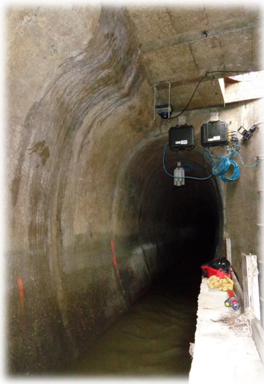
Poste de déversoir instrumenté à Ambérieu
