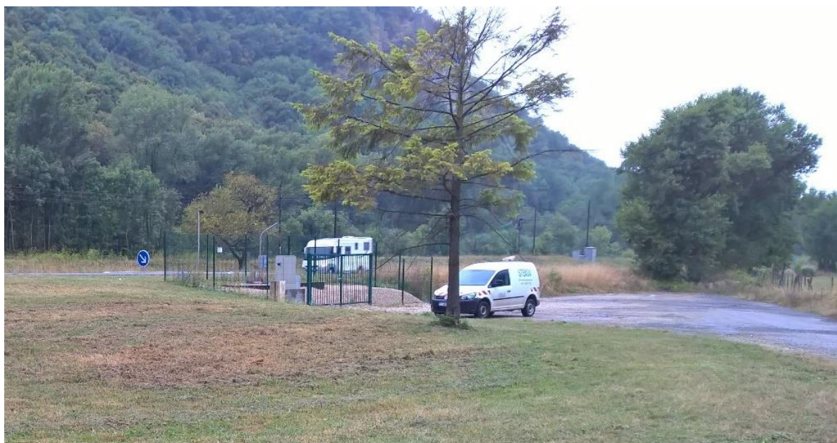
Les Postes de pompage de la ligne St Rambert Torcieu Ambérieu : PR-TRC-03
