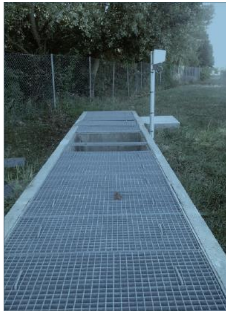
Venturi déversoir de tête de station
