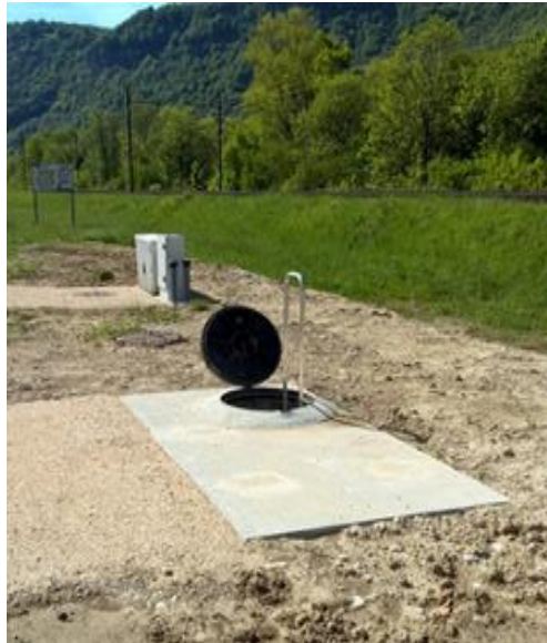
Système d'instrumentation du Déversoir de Torcieu réalisé en 2015
