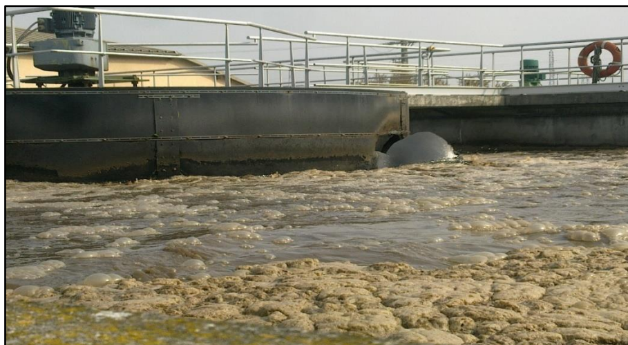
Bassin d'aération de la STEP des Blanchettes
