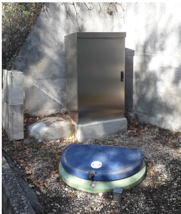
Nouvelle armoire électrique du poste de relèvement du Buizin à Saint Denis en Bugey
