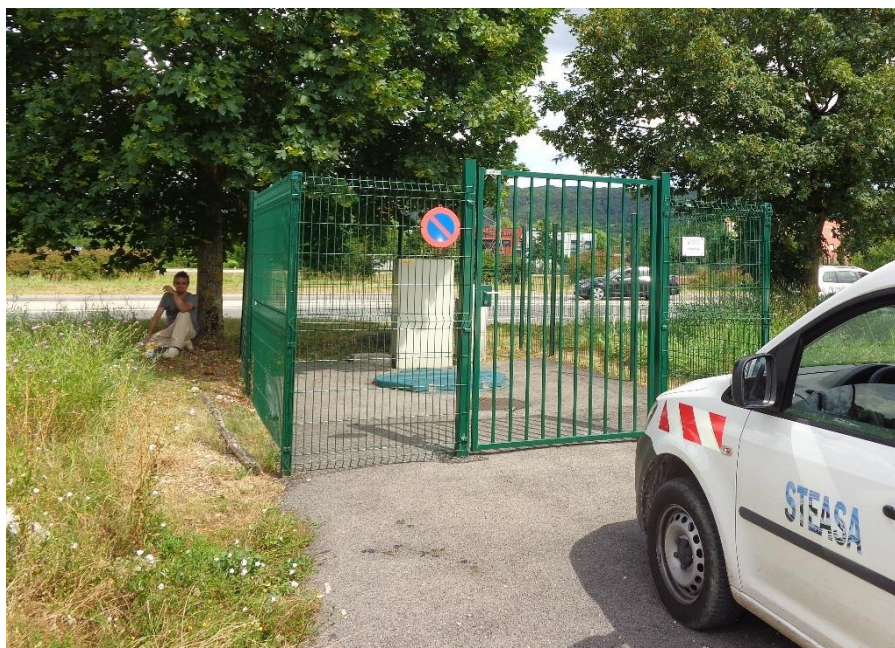
Poste de relèvement à PR-DVR-04 carrefour de l'aviation
