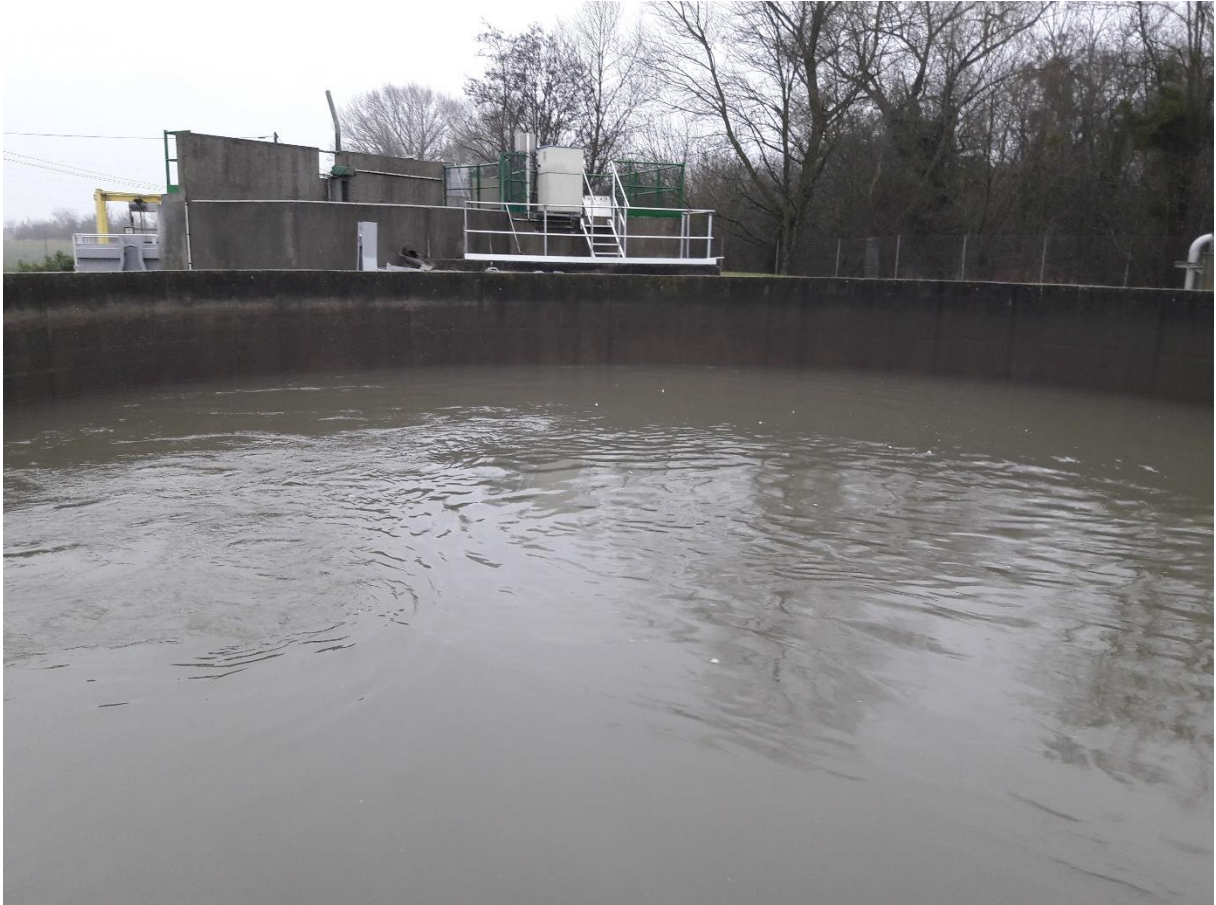
Bassin tampon de la station... plein
