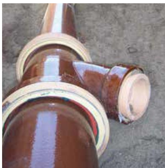
Canalisation et branchement grès
