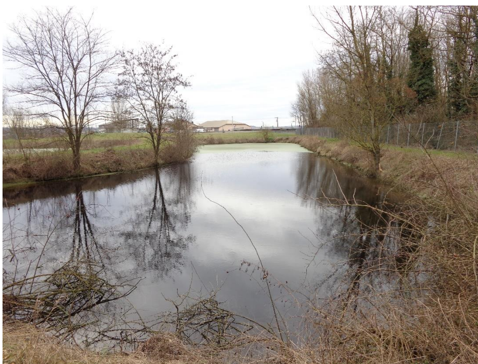
Bassins exutoires de la STEP des Blanchettes
