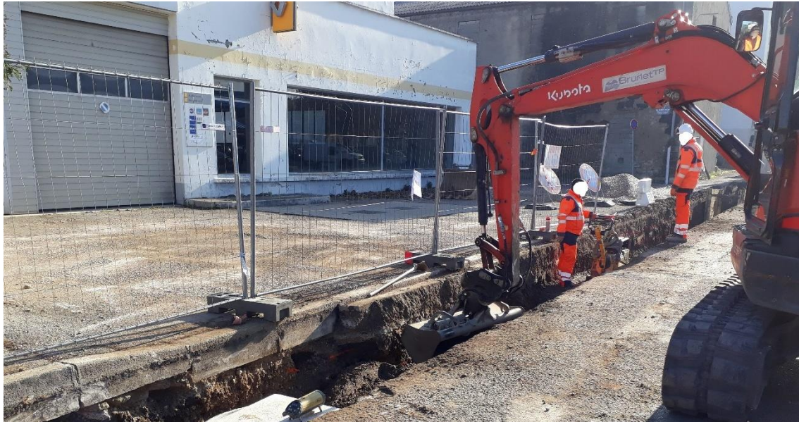
Travaux de construction du réseau EU en centre-ville
