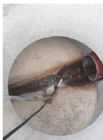
Entrée station, emplacement de la crépine (à l'installation, ce qui explique l'absence d'eau)
