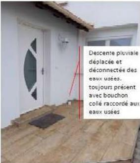
Descente pluviale déplacée et déconnectée des eaux usées. toujours présent avec bouchon collé raccordé aux eaux usées
