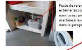
Poste de relevage externe raccordé aux eaux usées pour évier et machine à laver situé dans le garage
