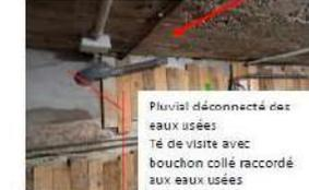
Pluvial déconnecté des eaux usées. Té de visite avec bouchon collé raccordé aux eaux usées
