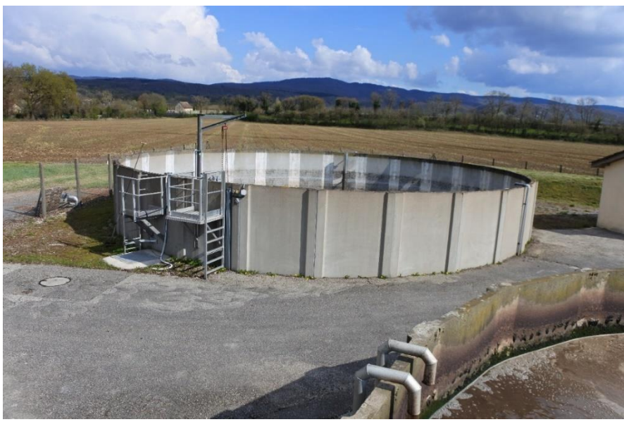
Bassin de stockage des boues liquides
